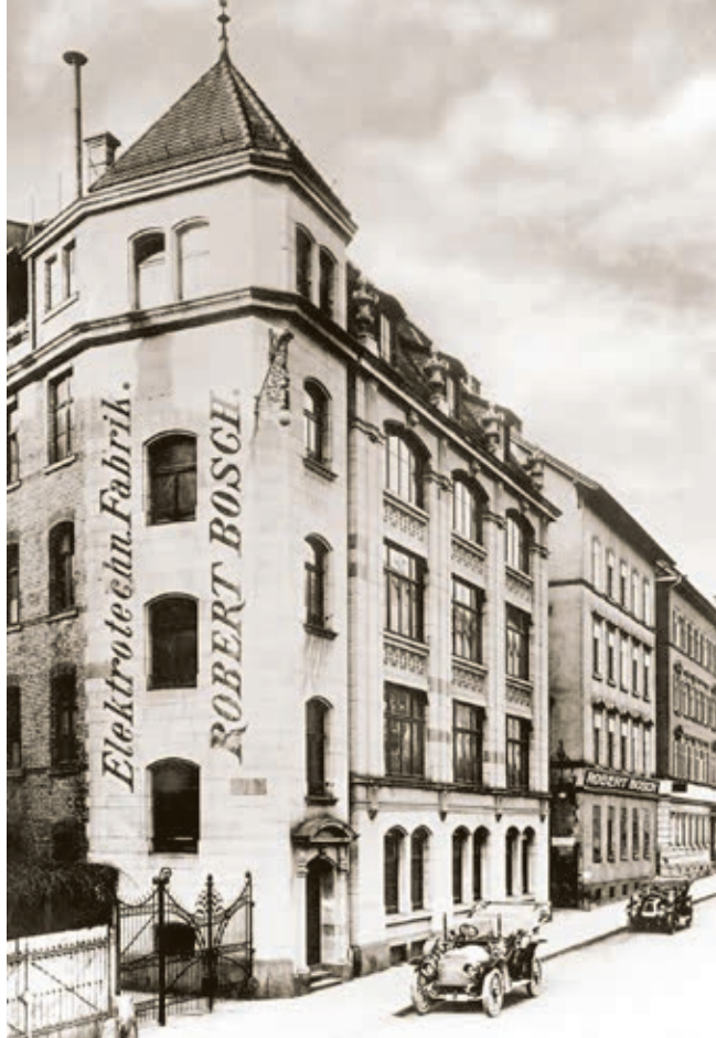
První vlastní tovární budova z roku 1901 v Hoppenlaustraße. Je to první stuttgartská budova, na níž byl použit železobeton. Zpočátku zde pracovalo 45 lidí, v roce 1906 už 450. Tehdy prý Robert Bosch prohlásil: „Teď už se nechceme rozšiřovat.“
